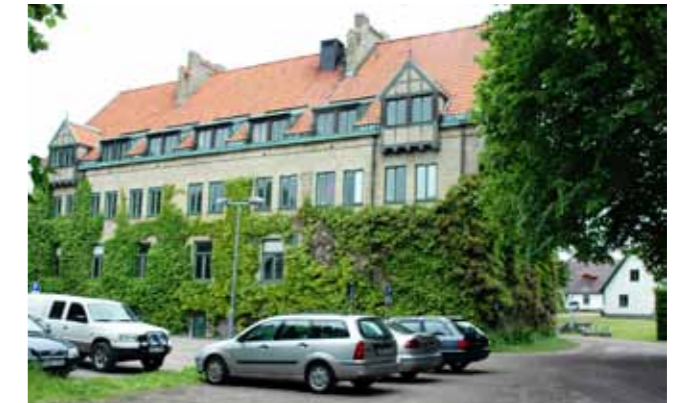
Lantbruksskolan - ombyggnad av f.d. lärosalar till tillgängliga student- och forskarbostäder
