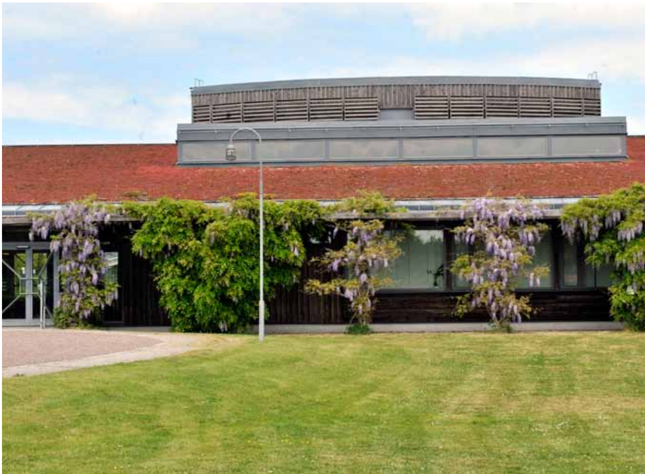
Navet- byggt 2002 med sedumtak och miljöcertifierat trä. Utskjutande takfot med spalje för blåregn (symbolväxt i Alnarp på grund av Slotets praktfulla blåregn) skuggar fönsterpartier. Spaljéer av trä skuggar gavlarnas generösa glaspartier från västersolen.
